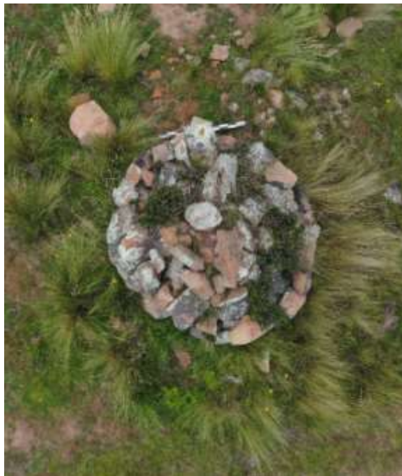
FOTO 30: E.C. 2. Vista aérea de la parte superior del techo o cubierta su estado de conservación.
