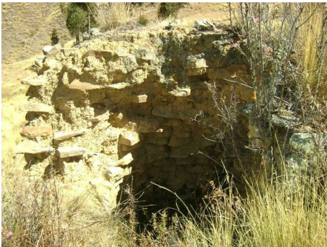
FOTO 32: Se observa el paramento interior con mortero color amarillo.
