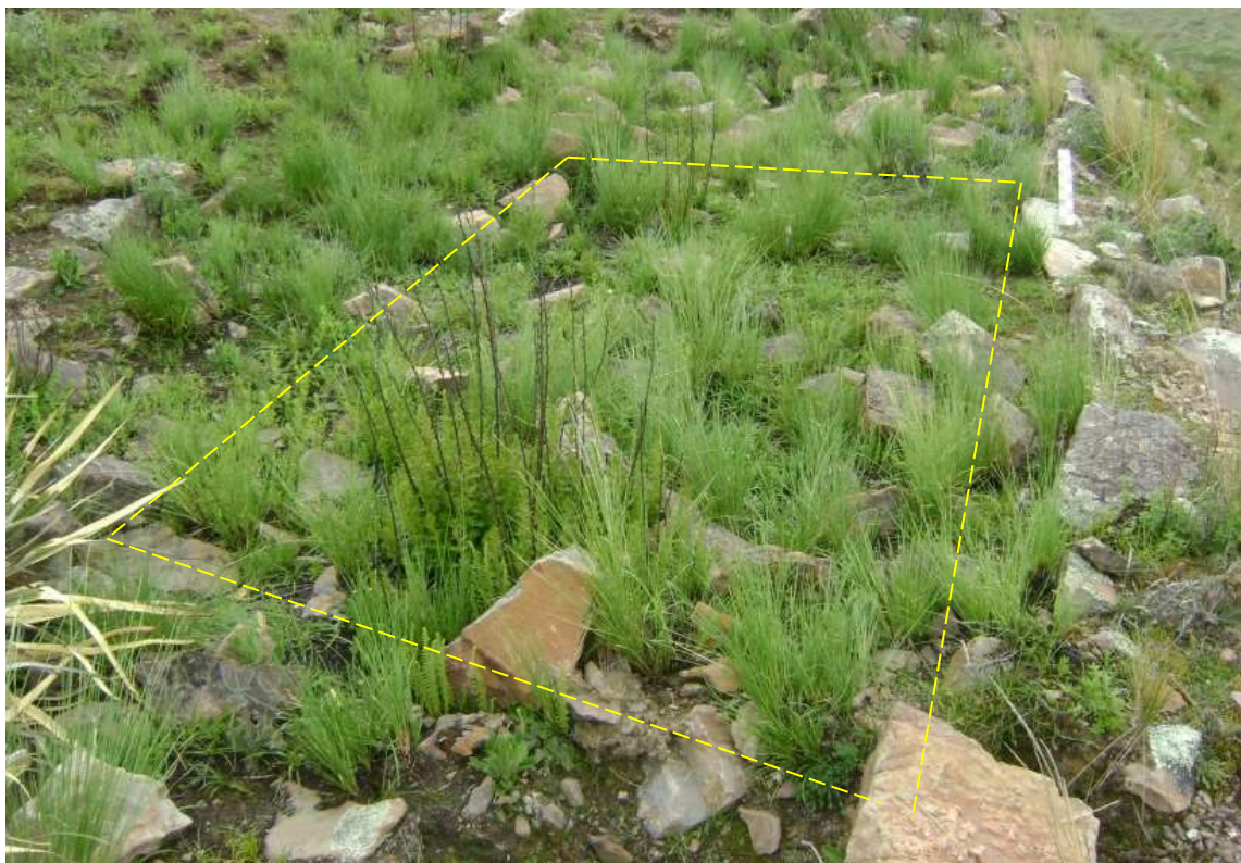
FOTO 18: E.R. 7. El muro de esta estructura en gran parte se encuentra colapsado y soterrado.
