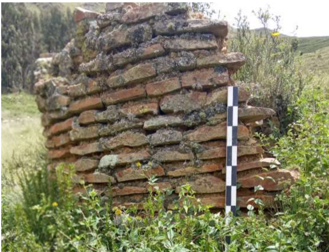
FOTO 31: Podemos observar el tipo de construcción de esta estructura.
