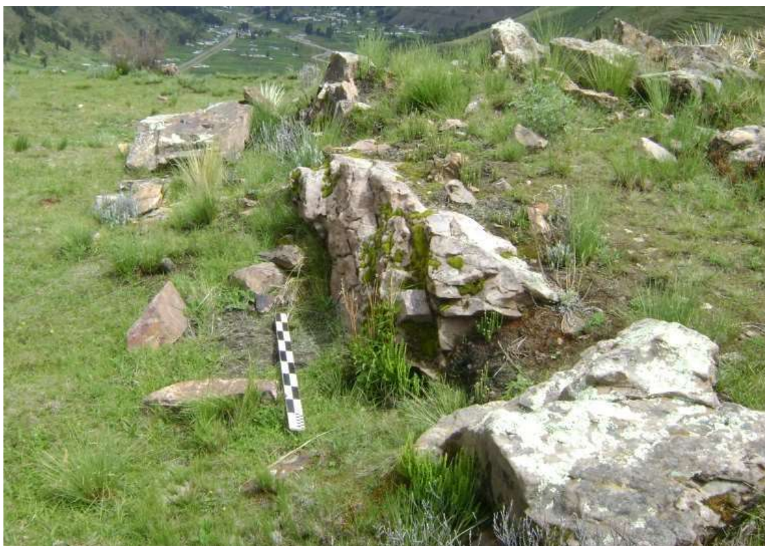
FOTO 20: M.C. 1. Podemos observar que los elementos han sufrido deslizamientos a causa de la vegetación.
