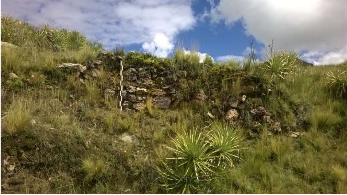
FOTO 21: M.C. 2 Muro de contención que se mantiene a pesar de la vegetación como se puede observar.
