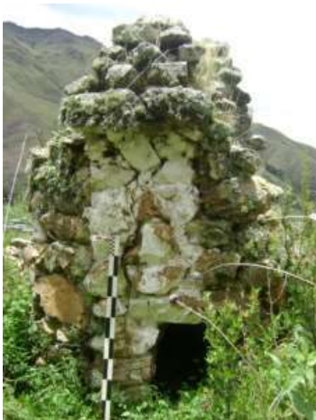
FOTO 1: E.C. 1. Se observa pintura blanca en el paramento de la estructura.
