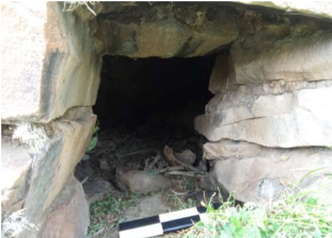
FOTO 28: M.P. 1. Se observar el vano de acceso
