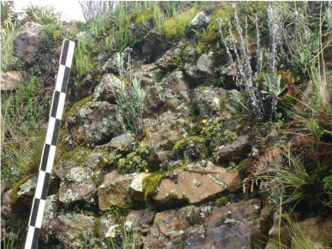
FOTO 22: M.C. 2. La estructura se encuentra al borde de colapsar por su construcción muy rustico.
