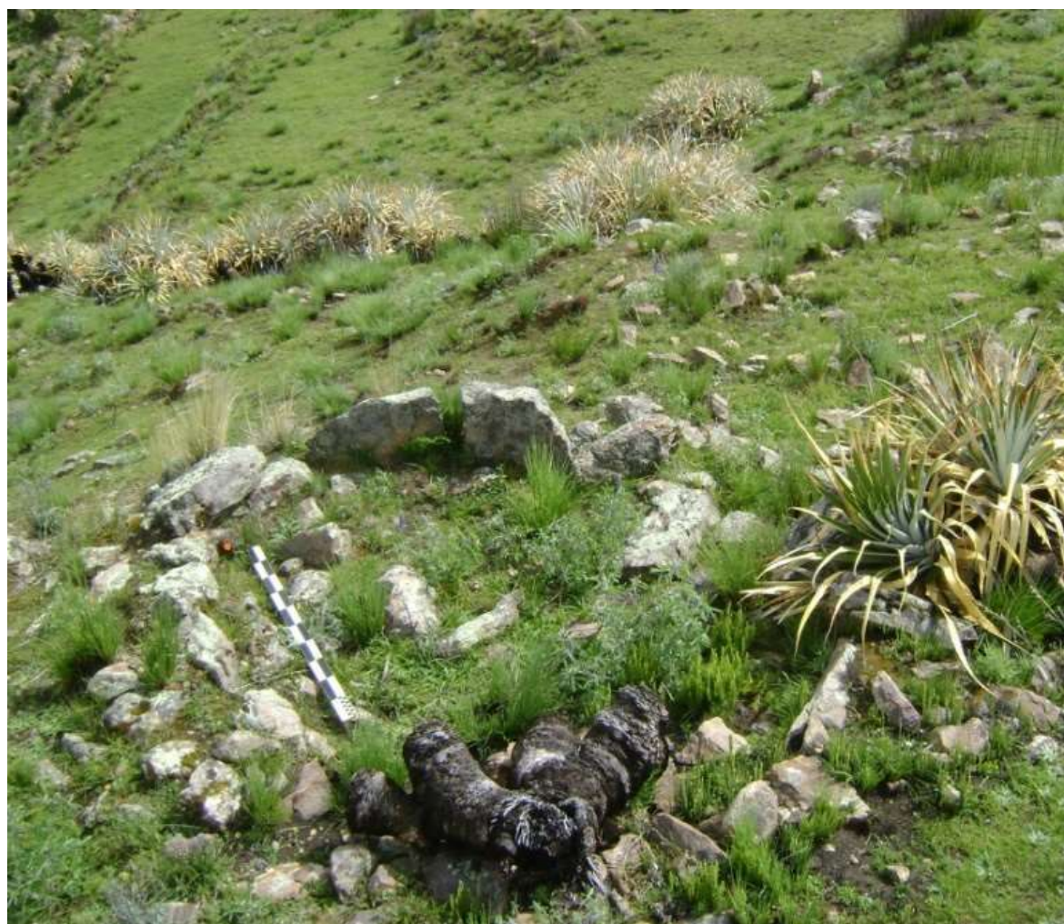
FOTO 12: E.C. 2. Los muros han ido colapsando a consecuencia de la vegetación
