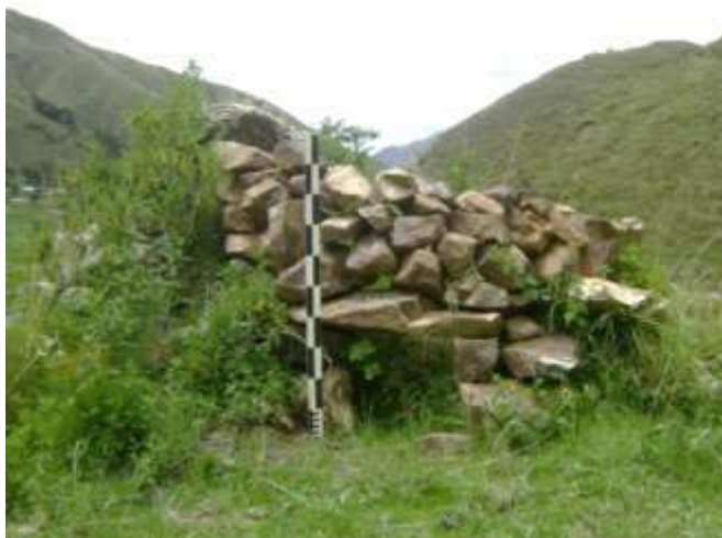
FOTO 2: E.C. 2. se observa el pircado en seco de manera provisional hecha aparentemente su acceso por la población.
