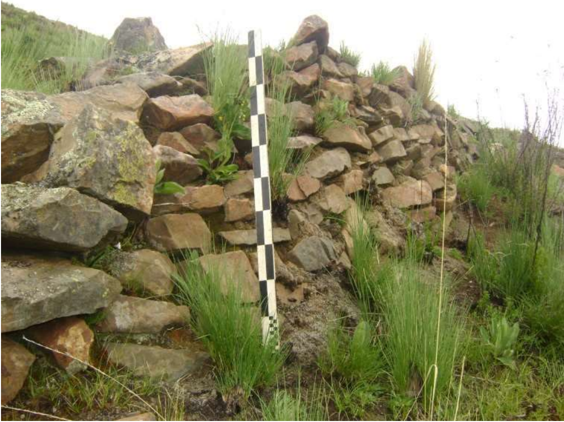
FOTO 23: M.P. 1. Su construcción es muy rustico, como se observa lajas de granito en medio de espacio con inclinación fuerte.
