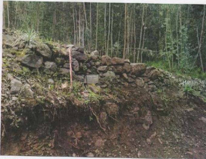
Foto N° 10, Vista del muro de contención del andén N° 27. Paisaje Arqueológico de Kullkunchayoq -Distrito de Calca, departamento de Cusco.
