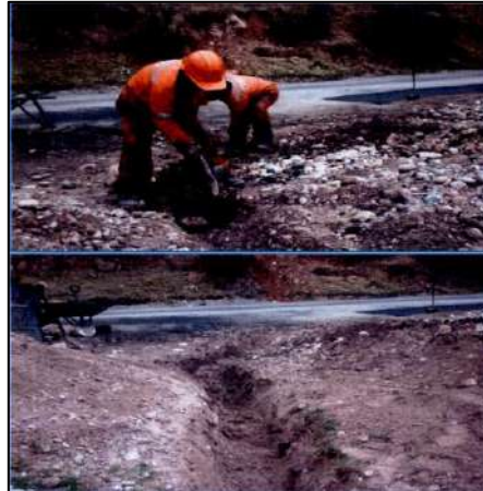
FIGURA 285: Ejemplo de reparación mayor de zanjas de drenaje
