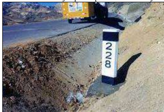
FIGURA 253: Ejemplo de poste de kilometraje
