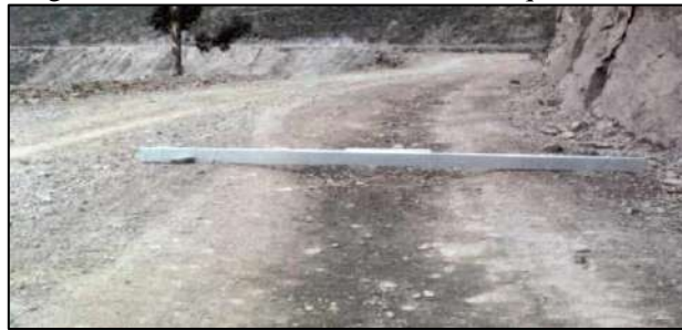
FIGURA 282: Ejemplo de superficie para reposición de afirmado con una deformación: gravedad3: huellas/hundimiento \geq que 10 cm
