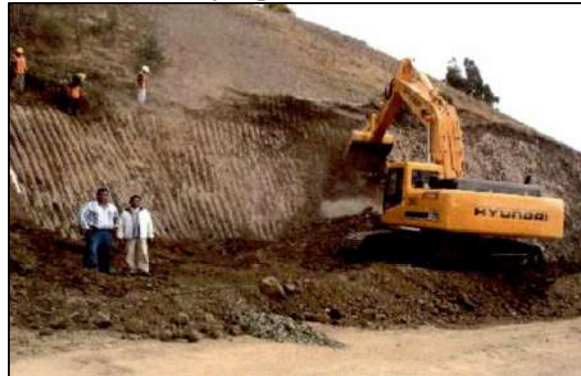
FIGURA 278: Ejemplo de Perfilado de Taludes
