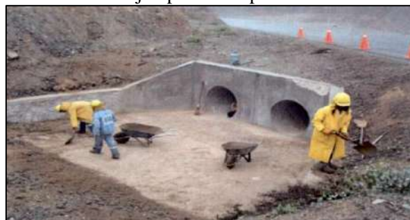
FIGURA 284: Ejemplo de limpieza de alcantarillas
