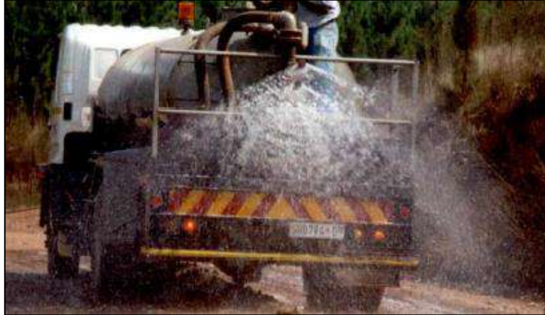
FIGURA 280: Ejemplo de Control de polvo mediante riego de agua
