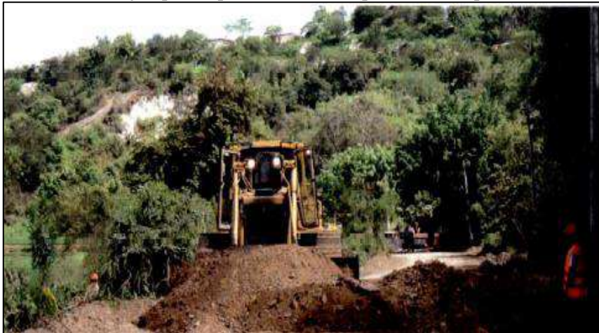
FIGURA 281: Ejemplo de perfilado se de superficie con aporte de material
