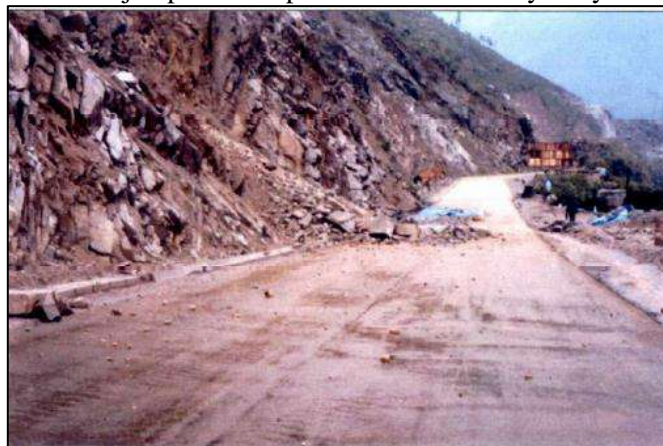
FIGURA 276: Ejemplo de limpieza de Derrumbes y huaycos menores
