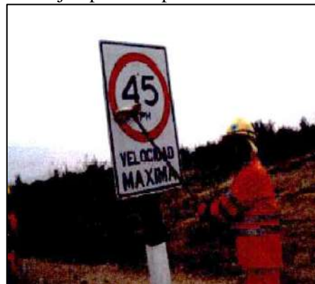
FIGURA 286: Ejemplo de reparación de señales verticales
