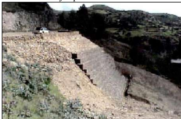
FIGURA 279: Ejemplo de estabilización de taludes
