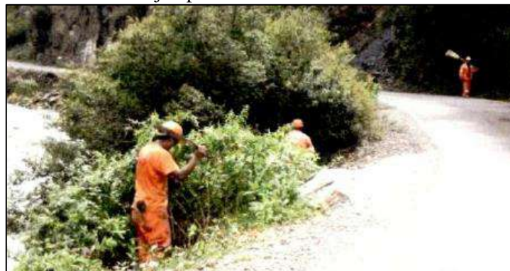
FIGURA 288: Ejemplo de conservación de derecho de vía
