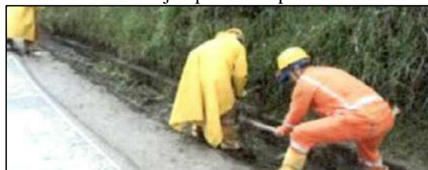
FIGURA 283: Ejemplo de limpieza de cunetas
