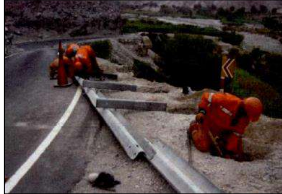
FIGURA 287: Ejemplo de reparación de guardavías metálicas
