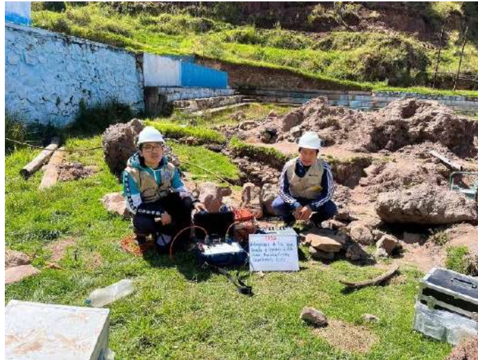
Figura 5.5 Equipo de prospección eléctrica de tomografía eléctrica
