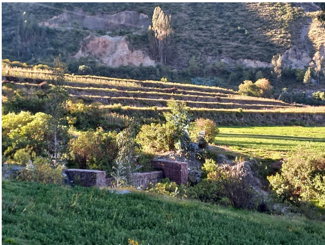
Figura 18 Sistema de gaviones implementados en el borde de los andenes de Q'enqo
