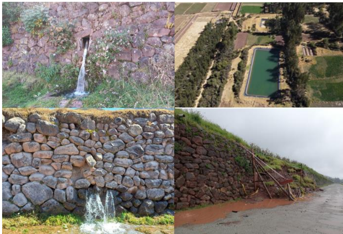
Figura 19 Consecuencias destructivas del andén, generado por las tecnologías modernas de riego
