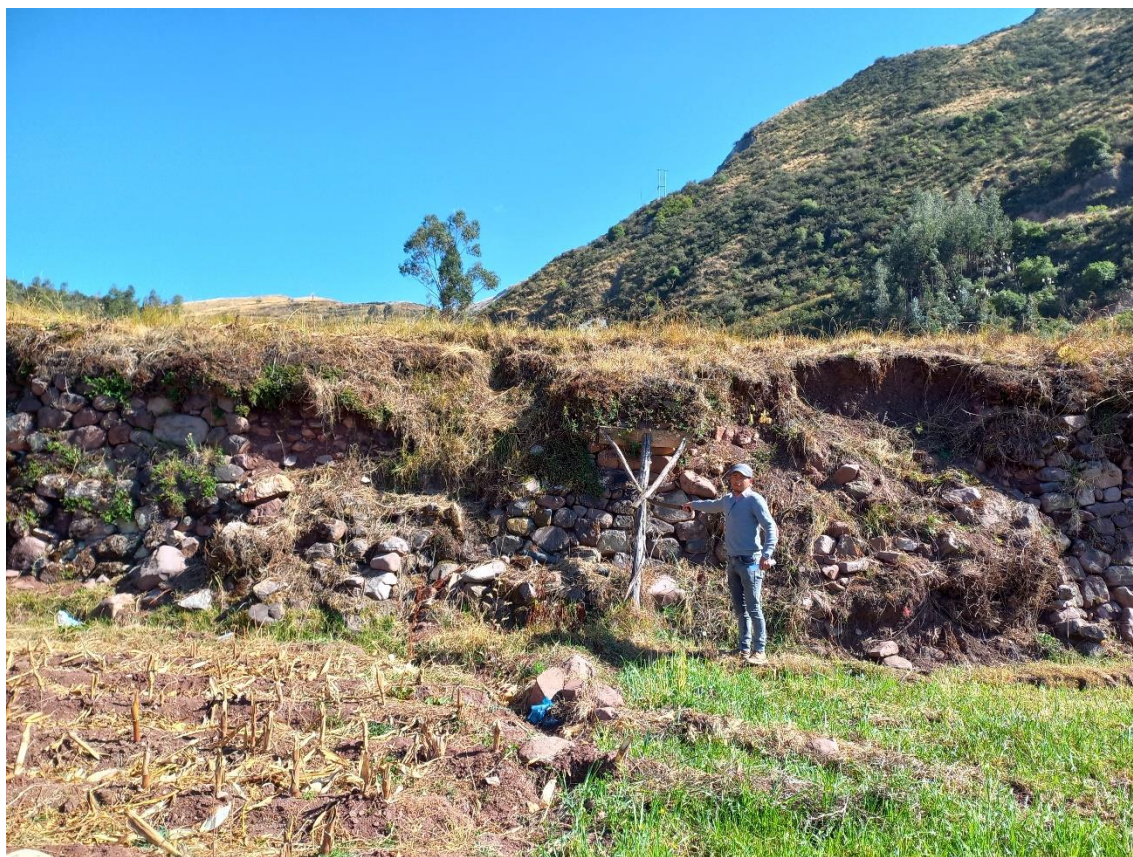
Figura 17 Proceso de destrucción de muros de andén
