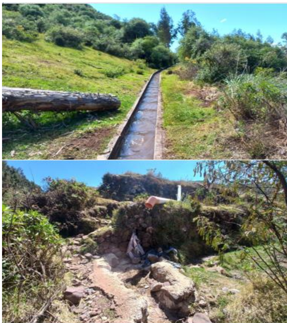
Figura 13 Tecnología hidráulica moderna en los andenes
