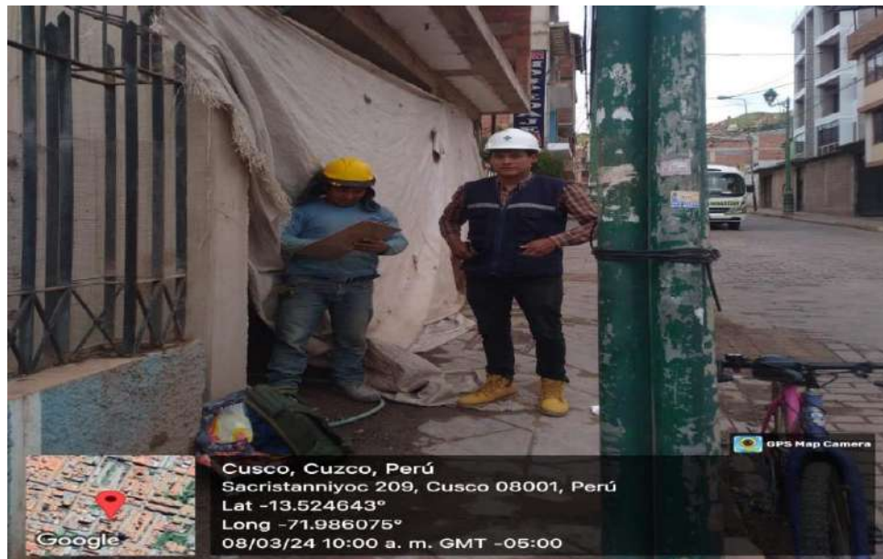
FOTOGRAFÍA N°38. Se aprecia la obra N°79 del distrito de Santiago
