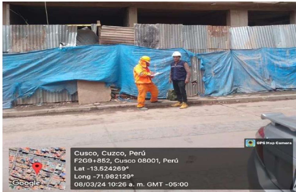
FOTOGRAFÍA N°39. Se aprecia la obra N°81 del distrito de Santiago
