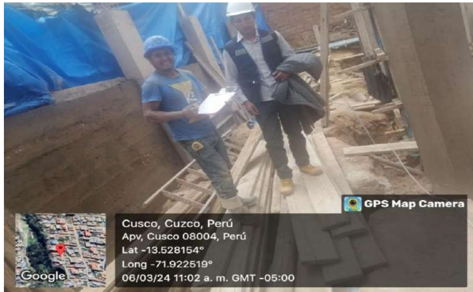
FOTOGRAFÍA N°20. Se aprecia la obra N°46 del distrito de San Sebastián
