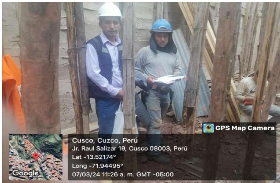
FOTOGRAFÍA N°44. Se aprecia la obra N°90 del distrito de Cusco
