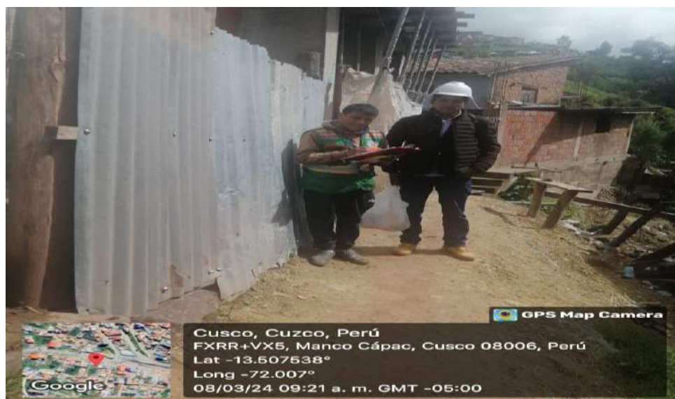
FOTOGRAFÍA N°54. Se aprecia la obra N°112 del distrito de Cusco
