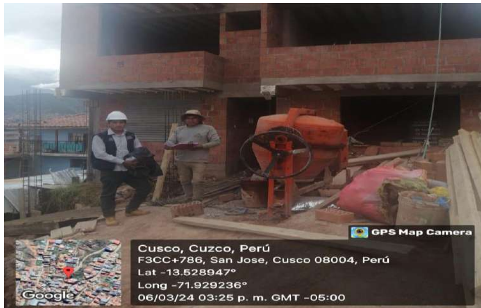
FOTOGRAFÍA N°22. Se aprecia la obra N°50 del distrito de San Sebastián
