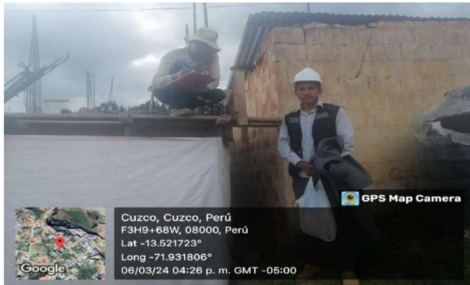
FOTOGRAFÍA N°27. Se aprecia la obra N°56 del distrito de San Sebastián
