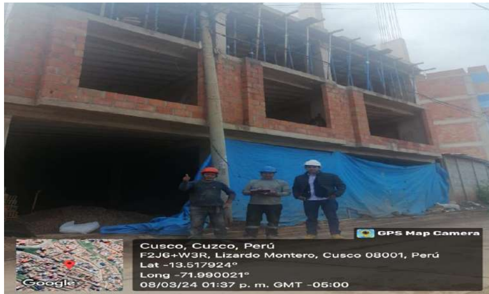
FOTOGRAFÍA N°45. Se aprecia la obra N°99 del distrito de Cusco
