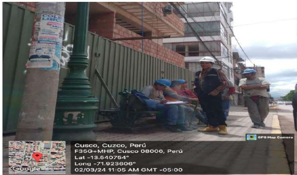
FOTOGRAFÍA N°28. Se aprecia la obra N°57 del distrito de Wánchaq
