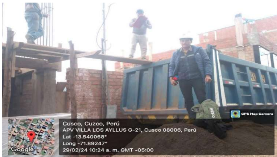
FOTOGRAFÍA N°8. Se aprecia la obra N°15 del distrito de San Jerónimo
