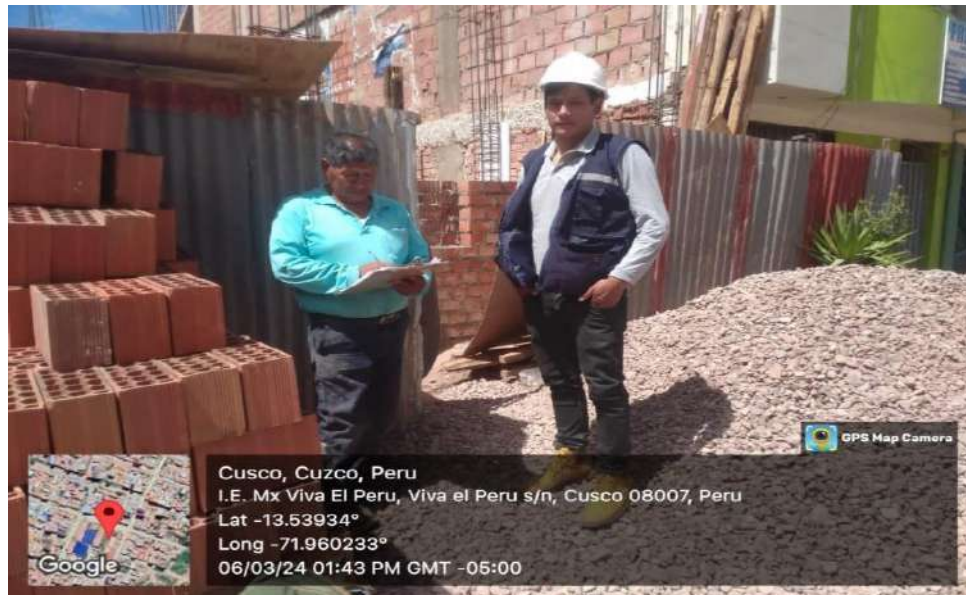
FOTOGRAFÍA N°33. Se aprecia la obra N°66 del distrito de Santiago
