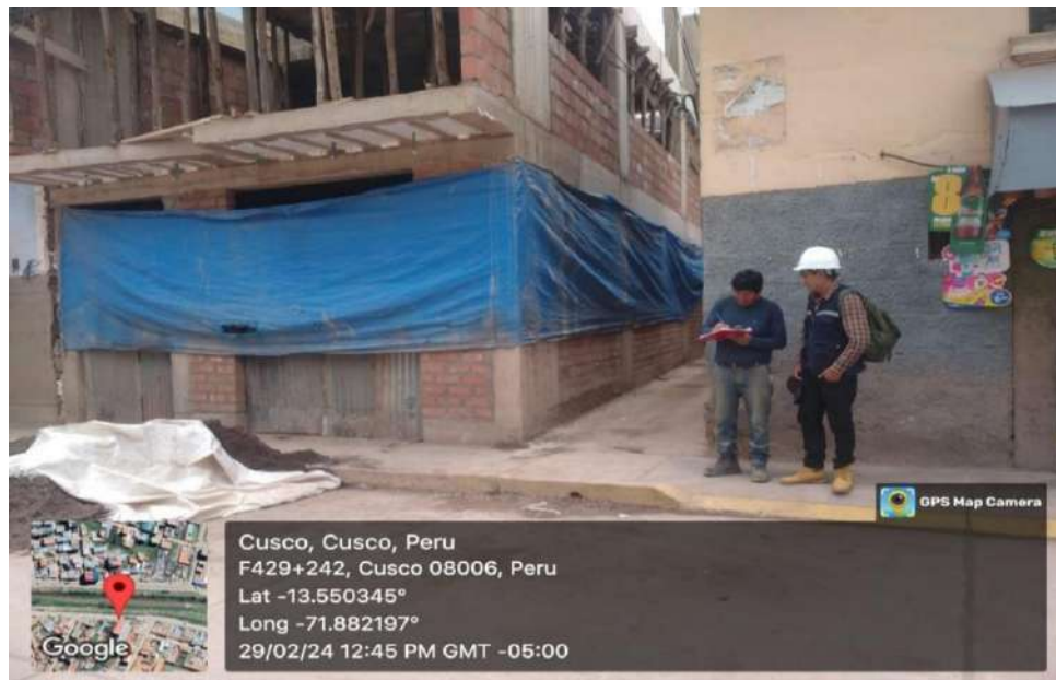
FOTOGRAFÍA N°4. Se aprecia la obra N°6 del distrito de San Jerónimo
