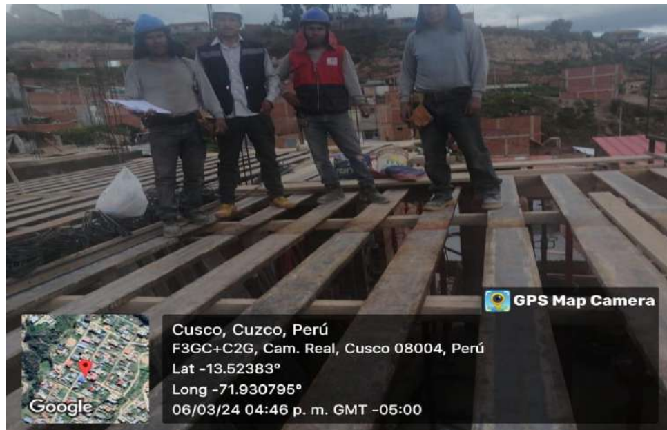
FOTOGRAFÍA N°26. Se aprecia la obra N°55 del distrito de San Sebastián
