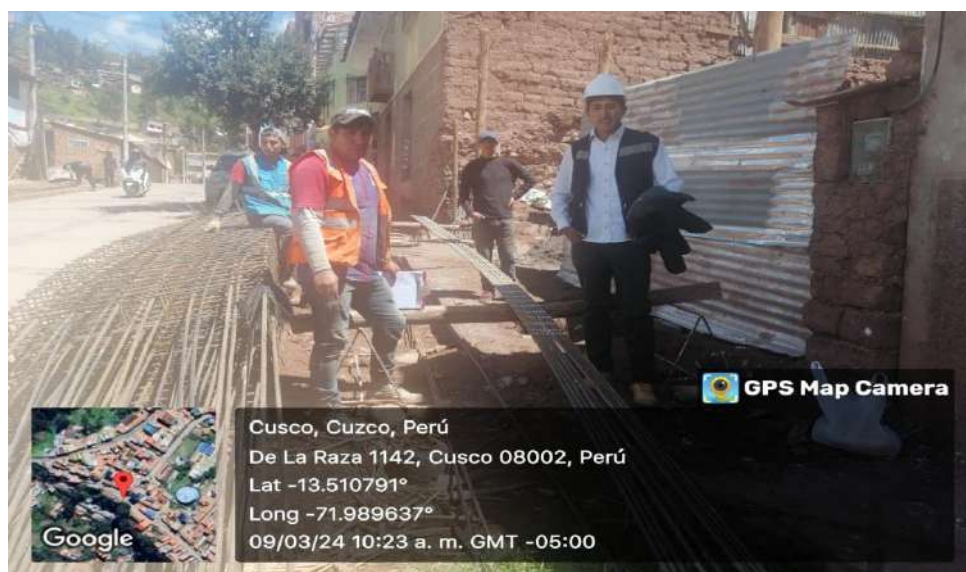
FOTOGRAFÍA N°49. Se aprecia la obra N°105 del distrito de Cusco
