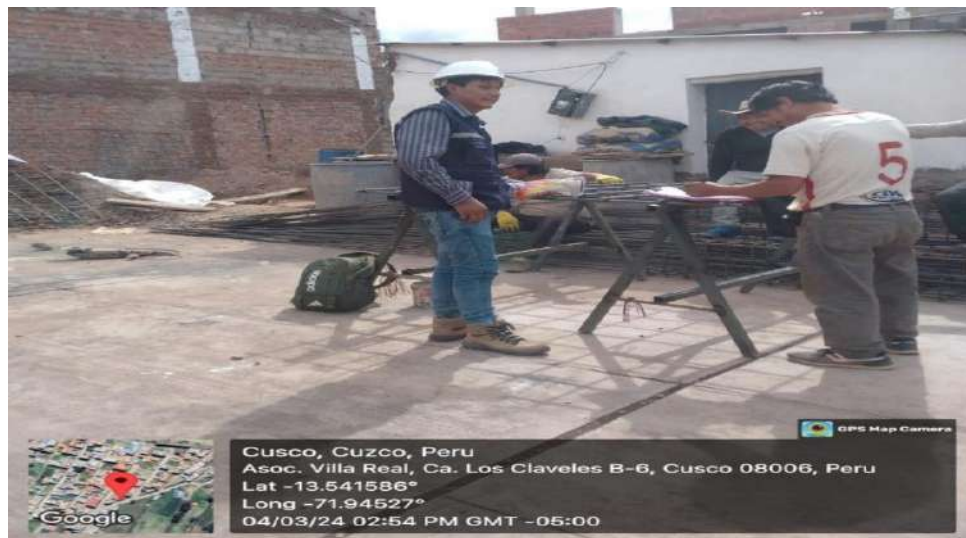
FOTOGRAFÍA N°15. Se aprecia la obra N°33 del distrito de San Sebastián
