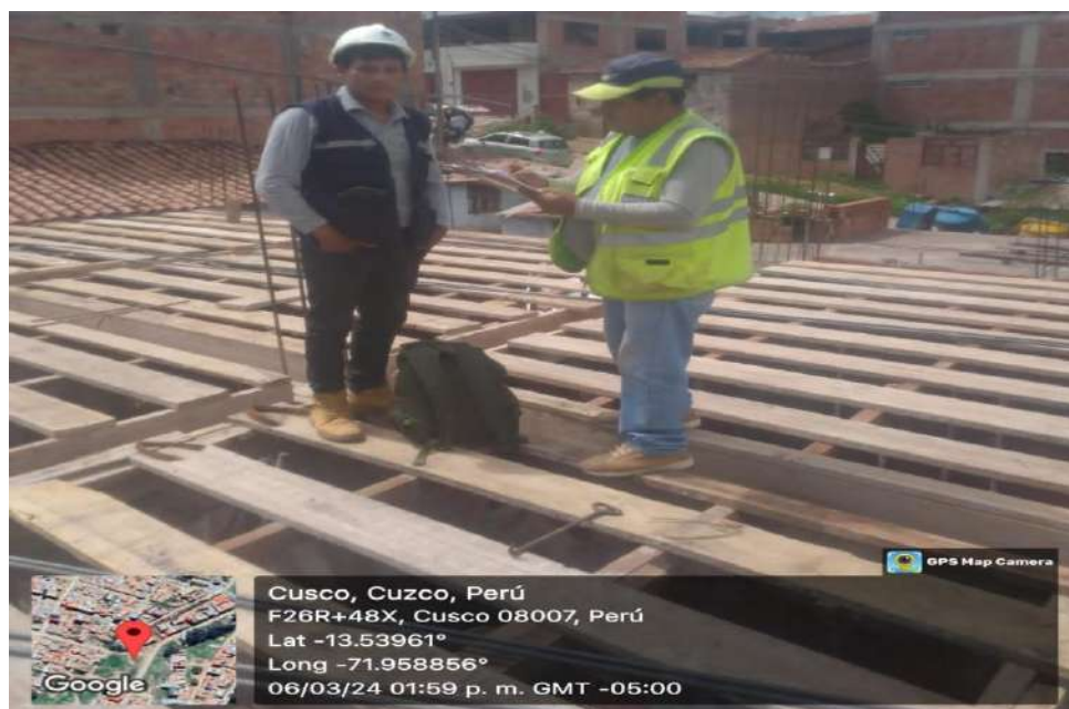
FOTOGRAFÍA N°34. Se aprecia la obra N°67 del distrito de Santiago
