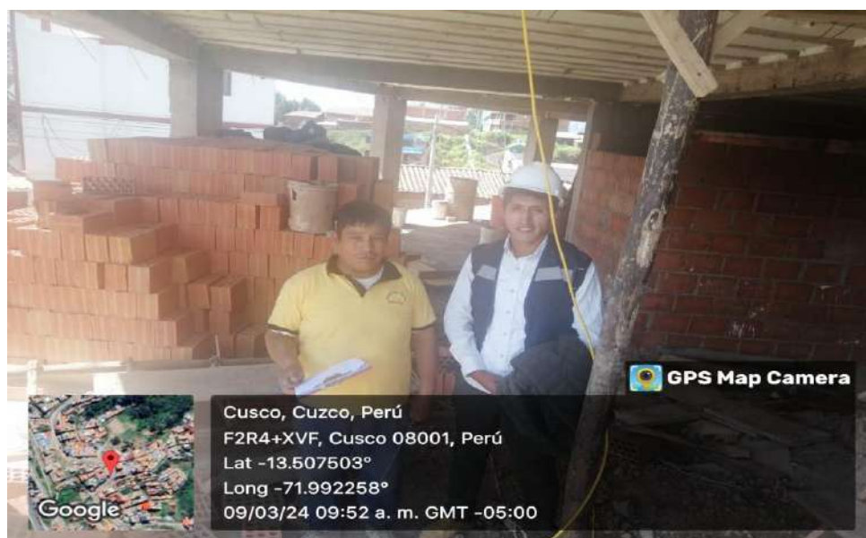
FOTOGRAFÍA N°51. Se aprecia la obra N°107 del distrito de Cusco
