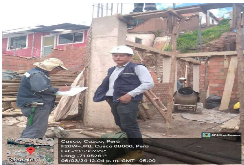
FOTOGRAFÍA N°16. Se aprecia la obra N°37 del distrito de San Sebastián
