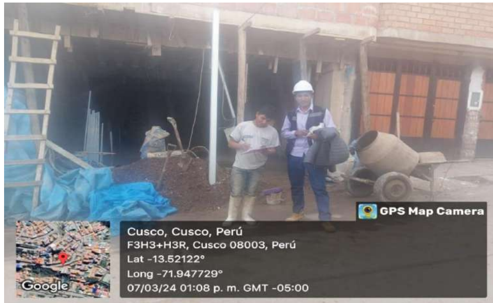
FOTOGRAFÍA N°43. Se aprecia la obra N°89 del distrito de Cusco
