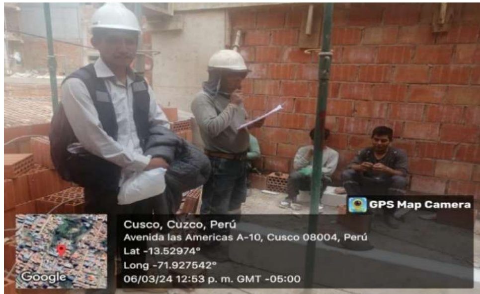
FOTOGRAFÍA N°21. Se aprecia la obra N°49 del distrito de San Sebastián
