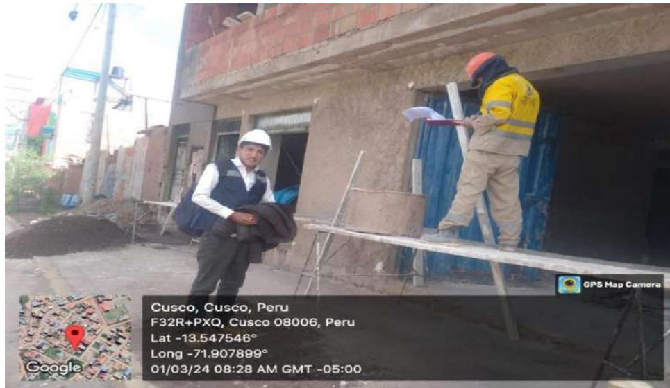
FOTOGRAFÍA N°9. Se aprecia la obra N°16 del distrito de San Jerónimo
