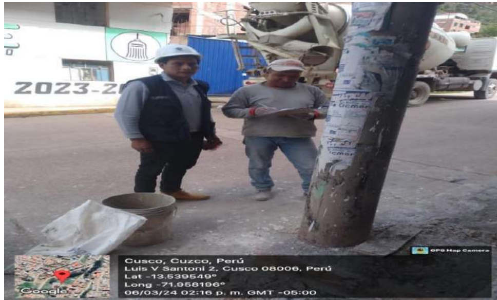
FOTOGRAFÍA N°35. Se aprecia la obra N°68 del distrito de Santiago
