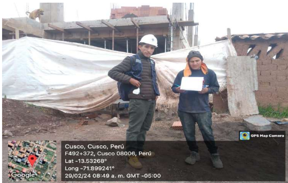
FOTOGRAFÍA N°10. Se aprecia la obra N°20 del distrito de San Jerónimo
