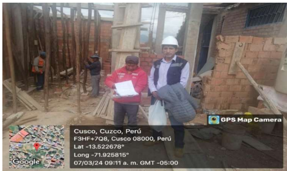
FOTOGRAFÍA N°24. Se aprecia la obra N°52 del distrito de San Sebastián
