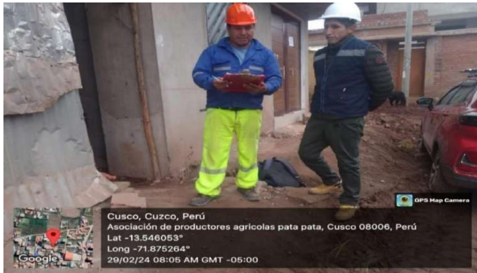
FOTOGRAFÍA N°11. Se aprecia la obra N°22 del distrito de San Jerónimo
