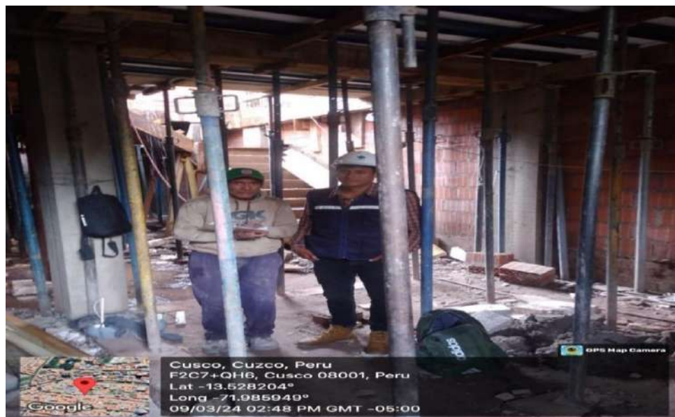
FOTOGRAFÍA N°40. Se aprecia la obra N°85 del distrito de Santiago
