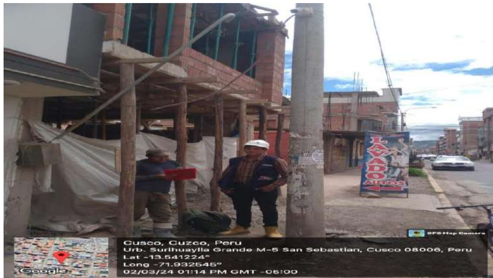
FOTOGRAFÍA N°12. Se aprecia la obra N°25 del distrito de San Sebastián
