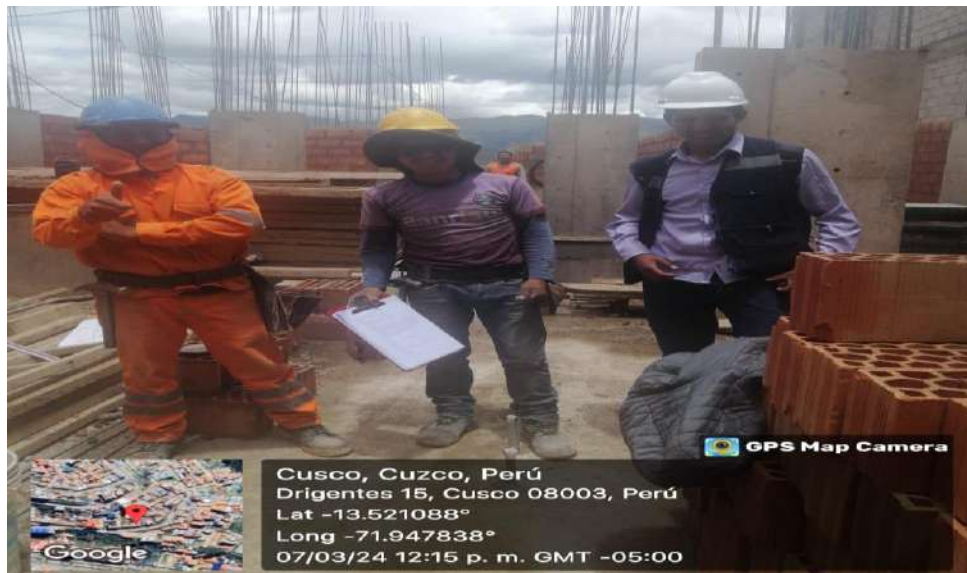
FOTOGRAFÍA N°42. Se aprecia la obra N°88 del distrito de Cusco
