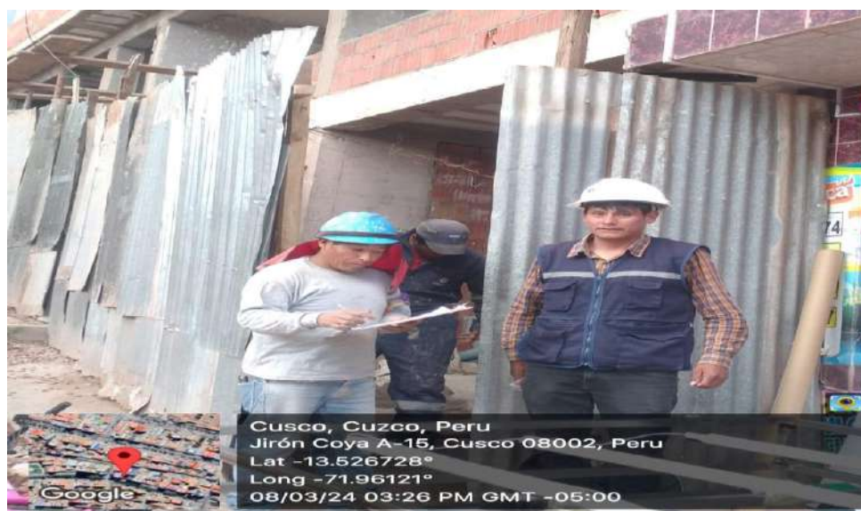
FOTOGRAFÍA N°13. Se aprecia la obra N°2 del distrito de San Sebastián
