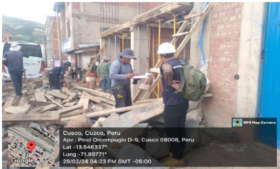
FOTOGRAFÍA N°6. Se aprecia la obra N°13 del distrito de San Jerónimo
