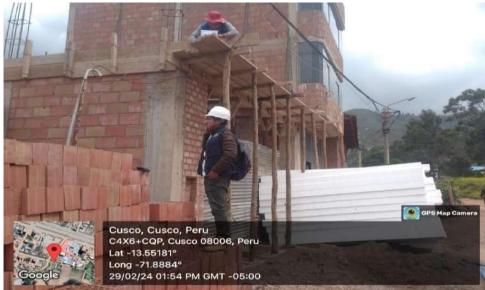
FOTOGRAFÍA N°5. Se aprecia la obra N°7 del distrito de San Jerónimo
