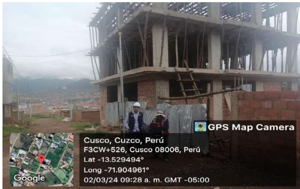
FOTOGRAFÍA N°18. Se aprecia la obra N°39 del distrito de San Sebastián
