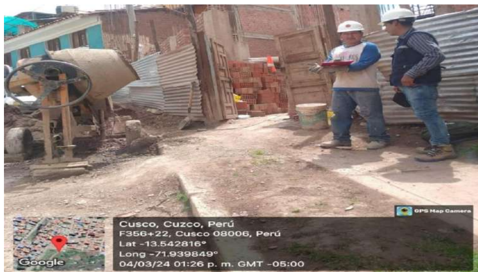
FOTOGRAFÍA N°14. Se aprecia la obra N°32 del distrito de San Sebastián
