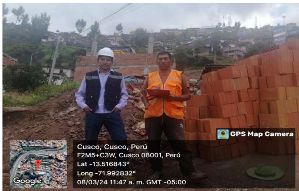
FOTOGRAFÍA N°48. Se aprecia la obra N°104 del distrito de Cusco
