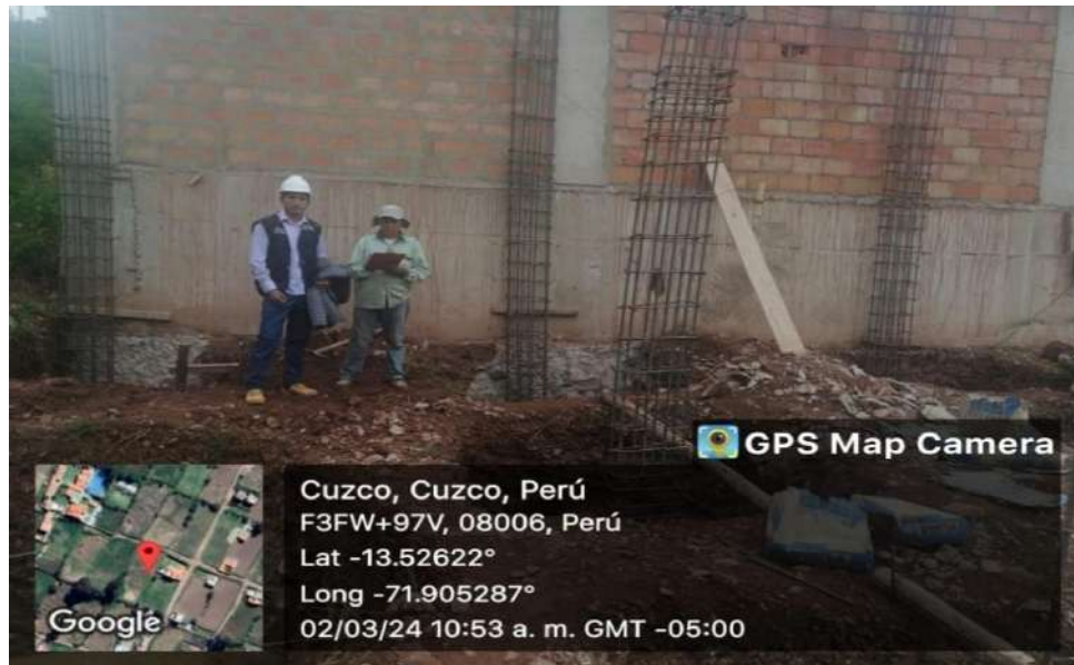
FOTOGRAFÍA N°19. Se aprecia la obra N°43 del distrito de San Sebastián
