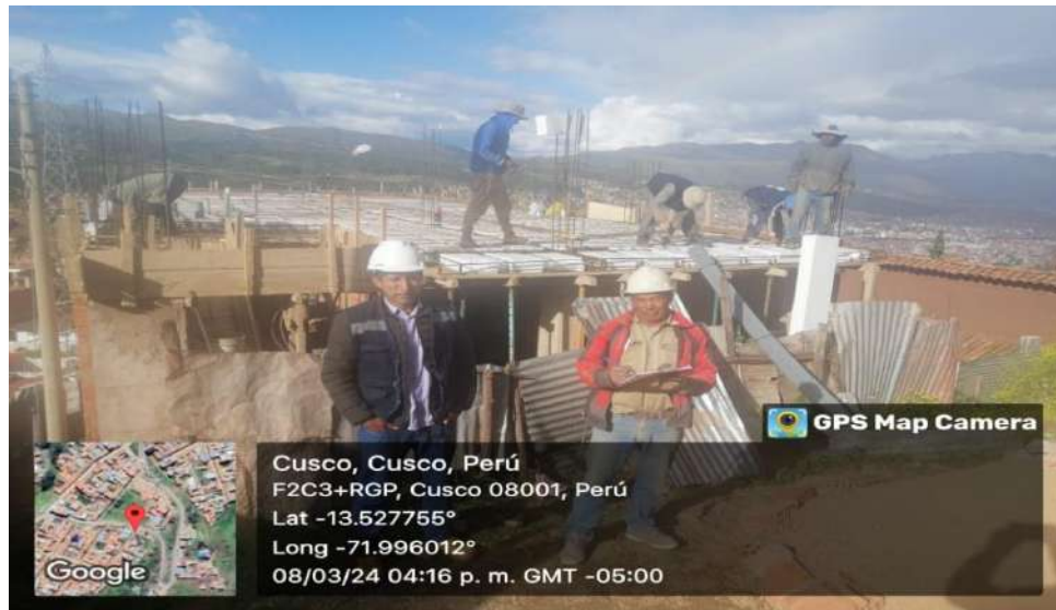
FOTOGRAFÍA N°55. Se aprecia la obra N°113 del distrito de Cusco
