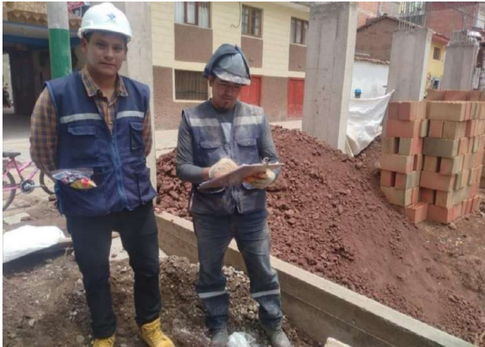
FOTOGRAFÍA N°31. Se aprecia la obra N°61 del distrito de Wánchaq
