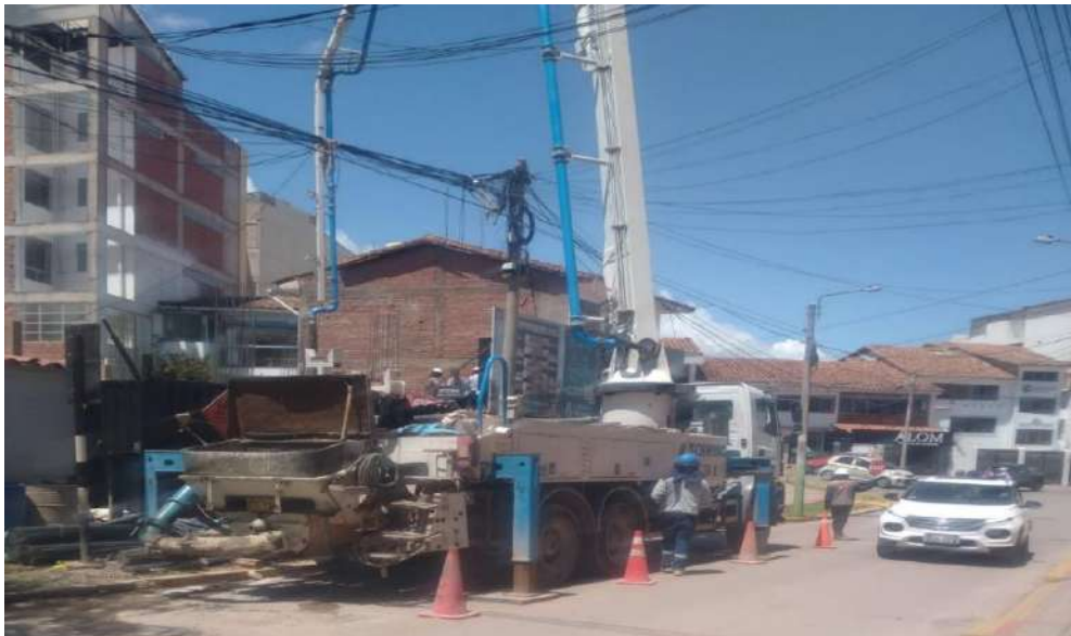
FOTOGRAFÍA N°32. Se aprecia la obra N°62 del distrito de Wánchaq
