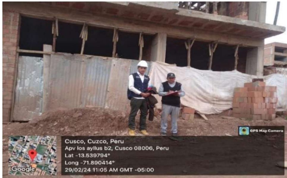
FOTOGRAFÍA N°7. Se aprecia la obra N°14 del distrito de San Jerónimo
