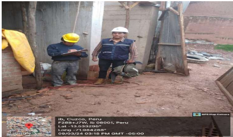
FOTOGRAFÍA N°41. Se aprecia la obra N°86 del distrito de Santiago
