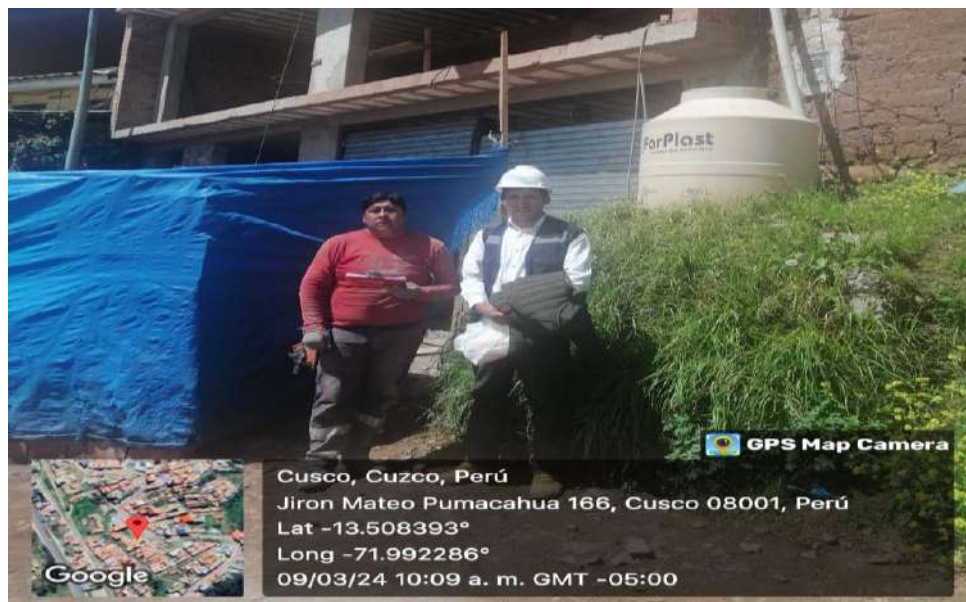
FOTOGRAFÍA N°50. Se aprecia la obra N°106 del distrito de Cusco
