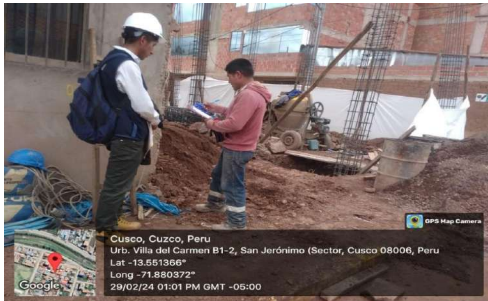
FOTOGRAFÍA N°3. Se aprecia la obra N°4 del distrito de San Jerónimo
