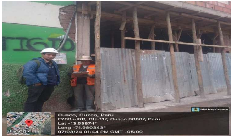
FOTOGRAFÍA N°37. Se aprecia la obra N°77 del distrito de Santiago
