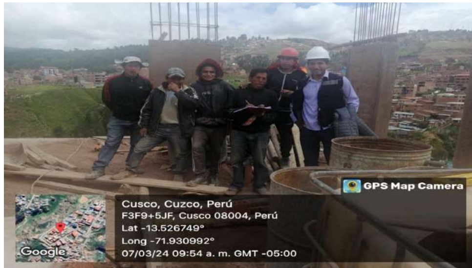
FOTOGRAFÍA N°25. Se aprecia la obra N°54 del distrito de San Sebastián
