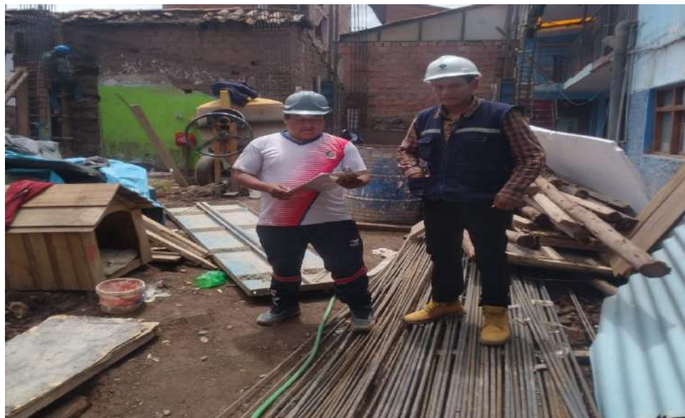
FOTOGRAFÍA N°30. Se aprecia la obra N°60 del distrito de Wánchaq
