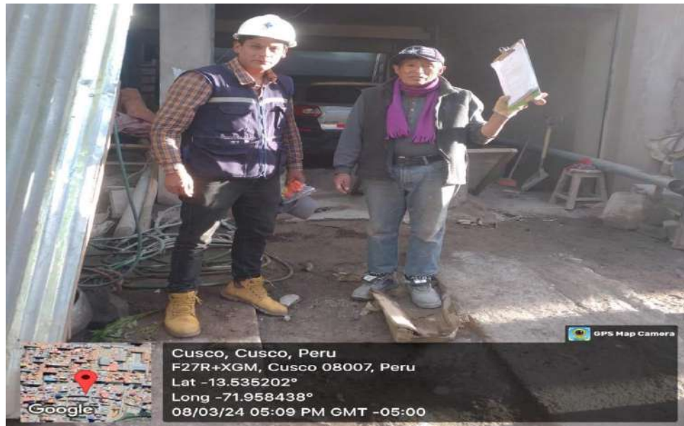
FOTOGRAFÍA N°29. Se aprecia la obra N°59 del distrito de Wánchaq
