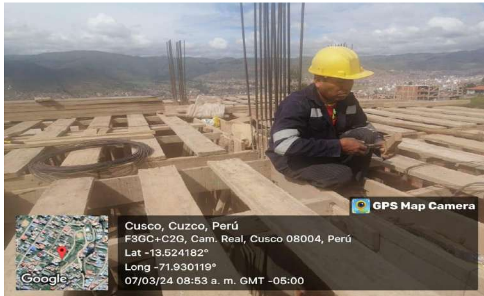
FOTOGRAFÍA N°23. Se aprecia la obra N°51 del distrito de San Sebastián
