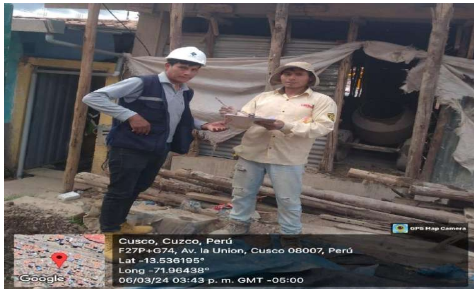
FOTOGRAFÍA N°36. Se aprecia la obra N°69 del distrito de Santiago
