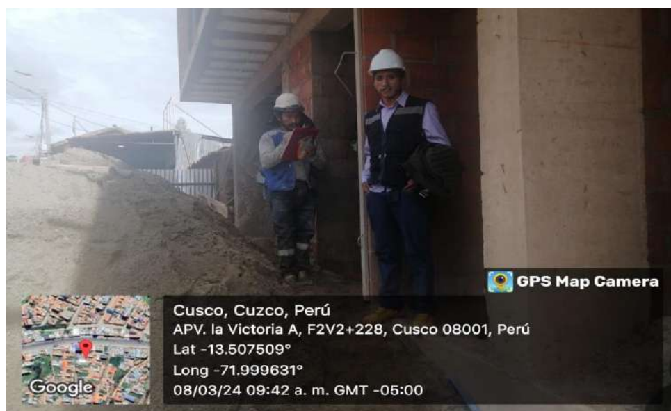
FOTOGRAFÍA N°53. Se aprecia la obra N°111 del distrito de Cusco
