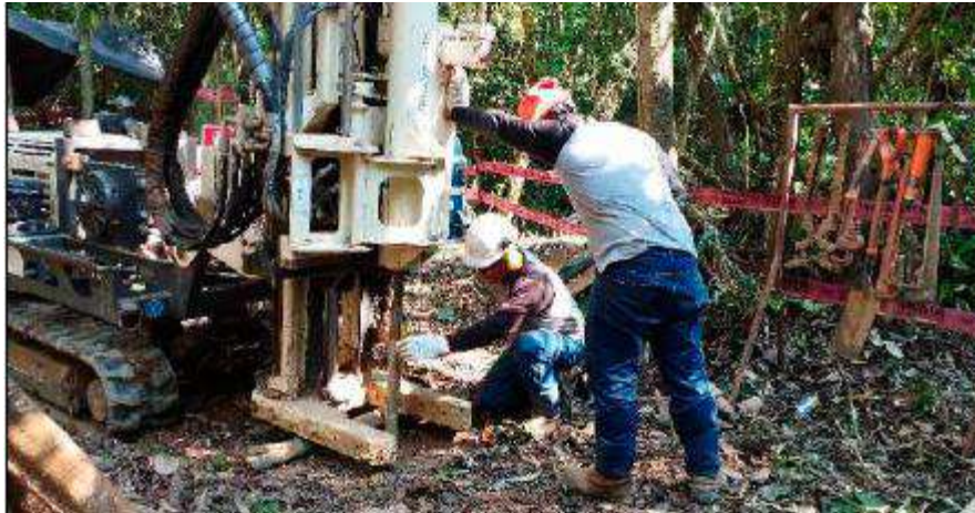
Figura 68: Labores de perforación por el método SPT mecánico, punto SPT - 5.
