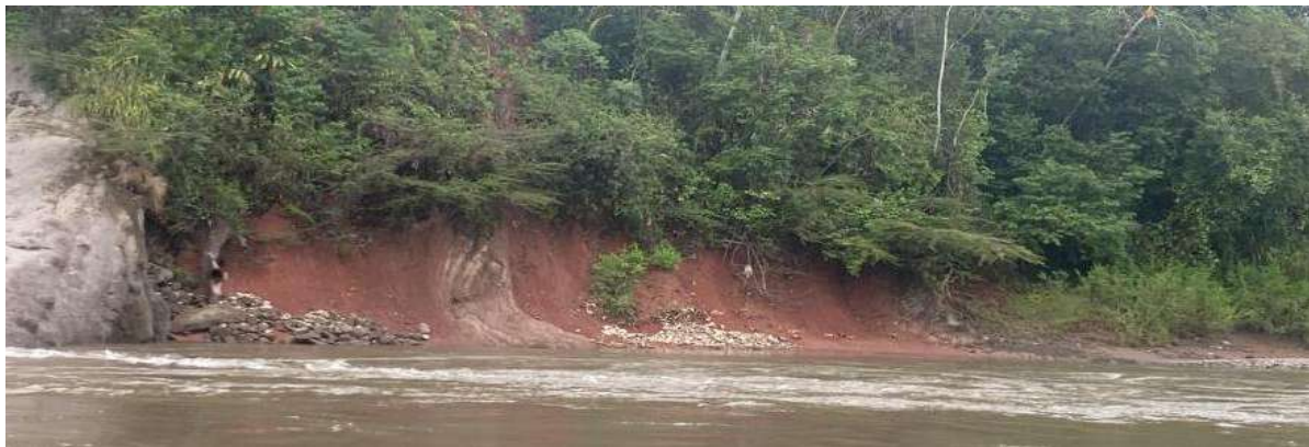
Figura 43: Erosión de ribera en margen izquierdo de rio Urubamba.
