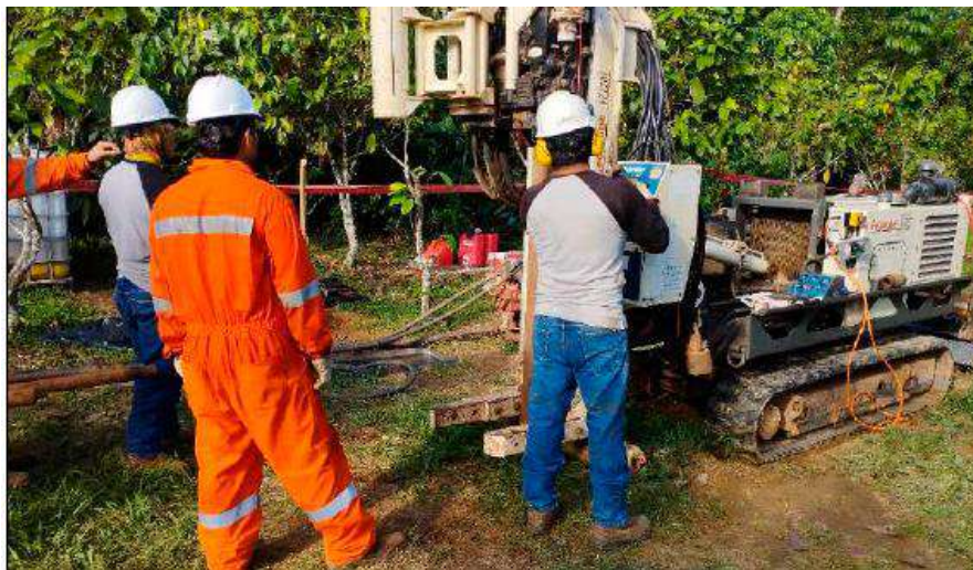
Figura 69: Labores de perforación por el método SPT 06 mecánico.
