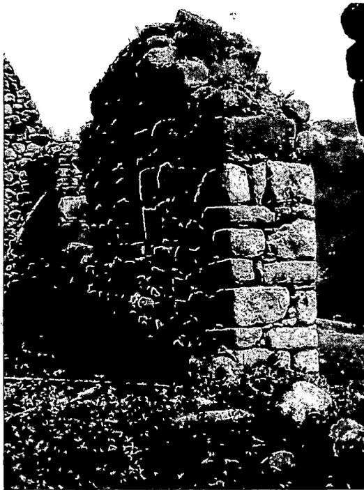
*Figura 58: esquina interior del vano de acceso del recinto R16 ubicado en el sector VI del C.A de Waynaq'ente. Nótese la posición de los líticos en "cabeza y soga", asentado que proporciona mayor estabilidad y anclaje en las esquinas. Fuente propia año 2009.*
