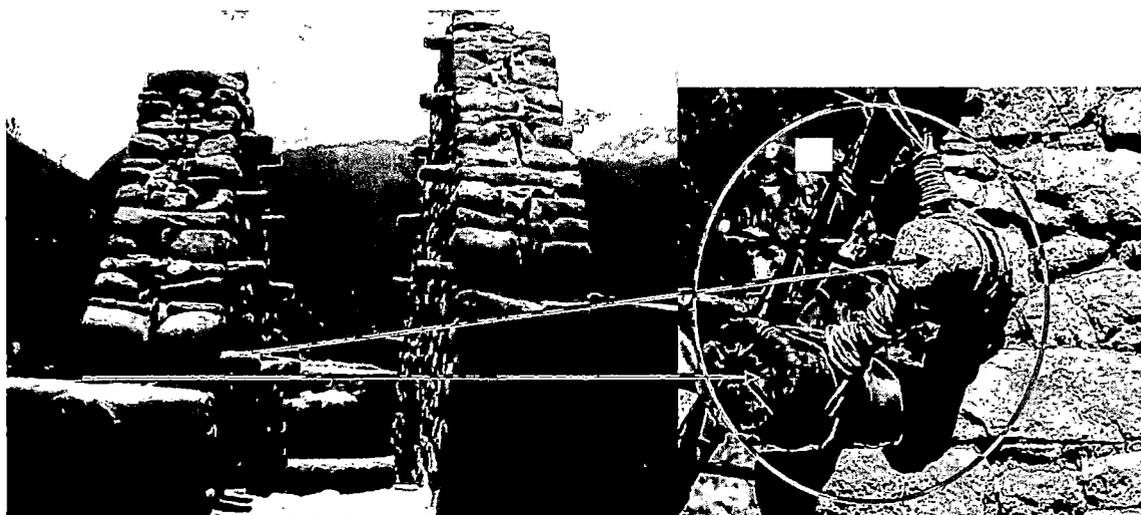
*Figura 75 Izquierda y 76 derecha: Detalle del atado de la estructura de cubierta al clavo que se encuentra en la parte inferior del hastial y al rollizo de madera que es puesto en la cajuela que se encuentra por debajo del primer clavo. Reconstrucción que se realizó en el C. A de Waynaq'ente año 2007 en el recinto R5. En la foto de la derecha se puede observar dicho atado, utilizándose en la acción, rollizos de madera, palos y cañas de curcur, atados con sogas de bijugo.*
