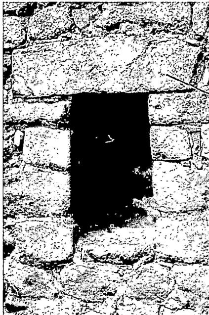
*Figura 69: Detalle del dintel de piedra de forma semi rectangular, constituye parte de una hornacina. Fuente propia año 2009.*
