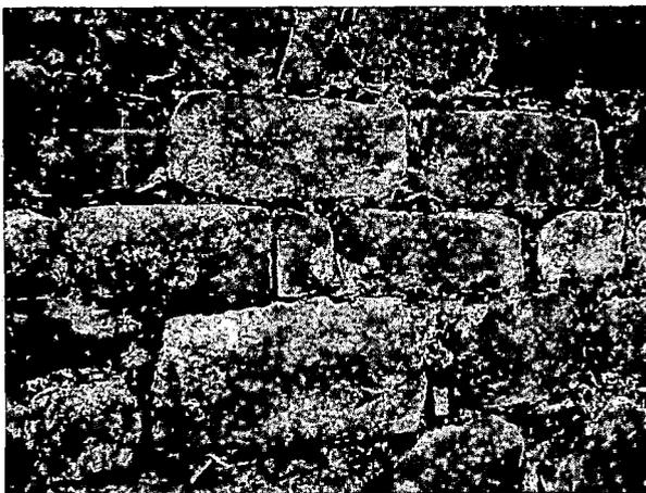
*Figura 59: mampostería construida mediante hileras. Fuente propia año 2009.*
