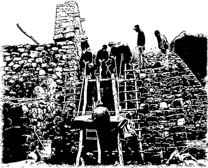
*Figura 55: manipulación y asentado del dintel proveniente del vano de acceso de doble jamba, utilizándose para ello, un plano inclinado, provisto de rollizos, escalera de palo y sogas con las cuales fue posible el asentado del bloque en la parte superior del vano de acceso. Participaron en dicha acción obreros del C. A de Waynaq'ente. Fuente propia año 2009.*
