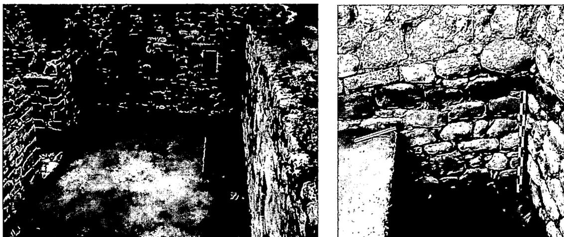
*Figuras 44 y 45: Detalle de la esquina Este del recinto R7, donde se apertura una cala para definir la profundidad de la cimentación, a su costado la imagen muestra la profundidad de la cimentación y su adecuación sobre el afloramiento rocoso. Fuente César Soria año 2007.*
