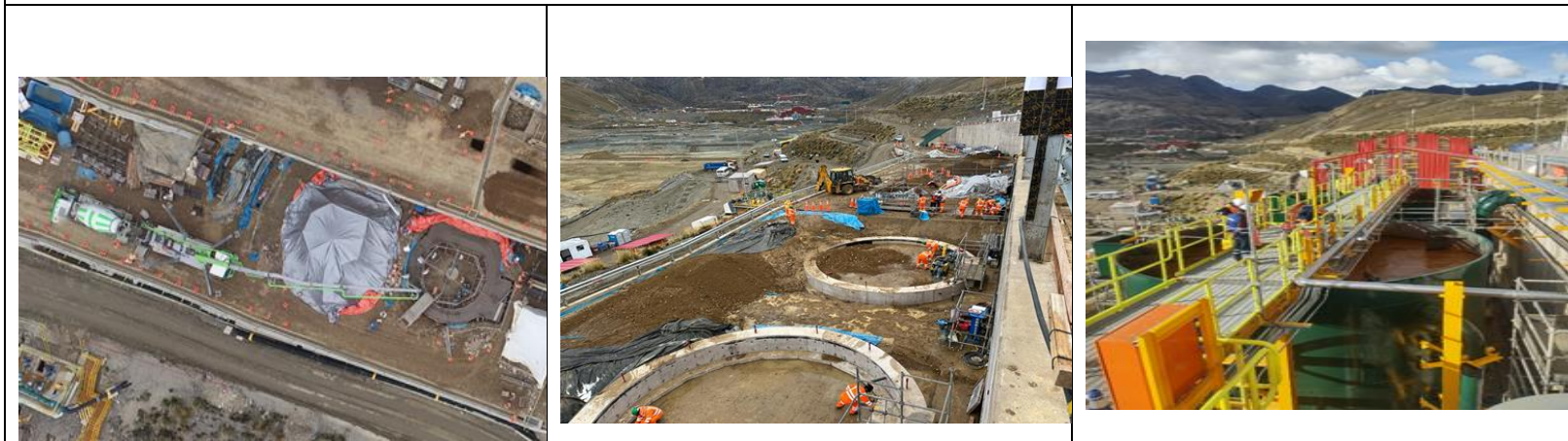
Construcción de Bases y Tanques Reactores
