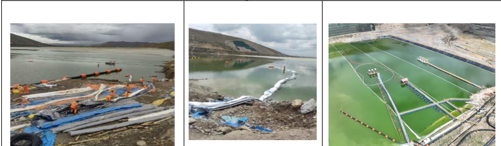
Instalación de Bafles en Pond B3
