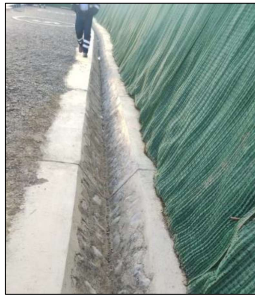
Imagen N°02: Inspección de limpieza de cunetas y pozos
