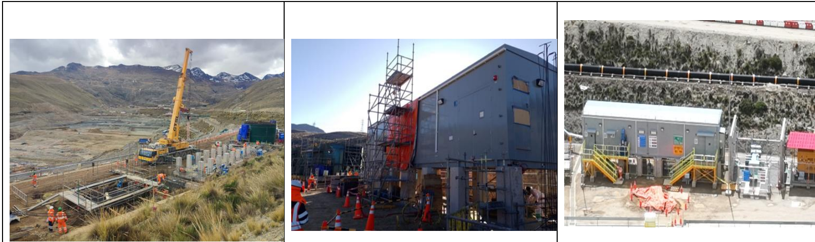
Construcción de Bases e Instalación de Sala Eléctrica 6250-ER-01
