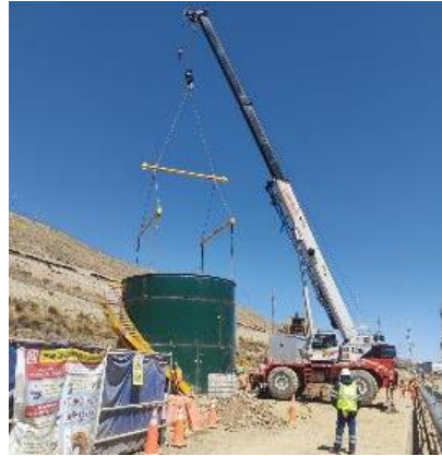
Montaje de Tanque de Agua de Procesos
