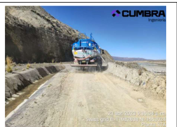
Imagen N°20: Regado de Vías
