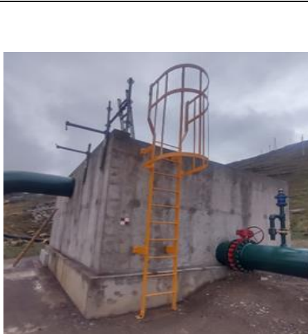
Construcción de Cajón de Paso 1
