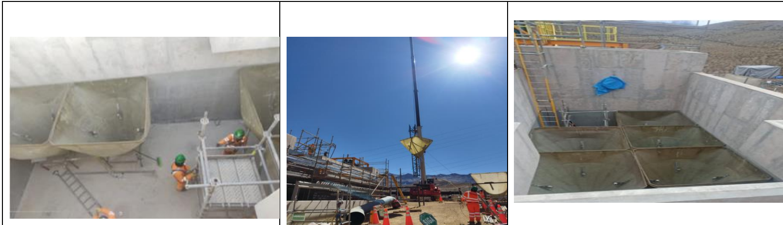
Instalación de Conos de Fibra en interior de Cajones de Filtro
